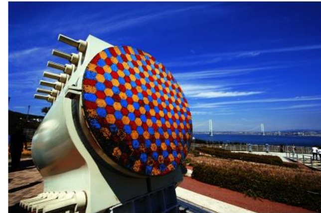
Coupe transversale d'un câble du pont Akashi kaikyo - Japon
